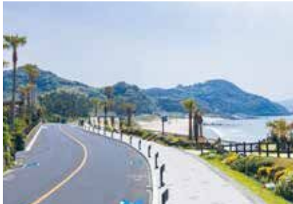
〈北崎地区の無電柱化された道路〉
