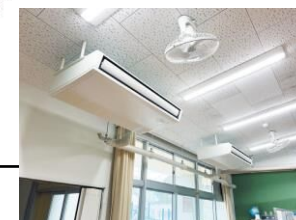
宮崎市小学校空調整備
