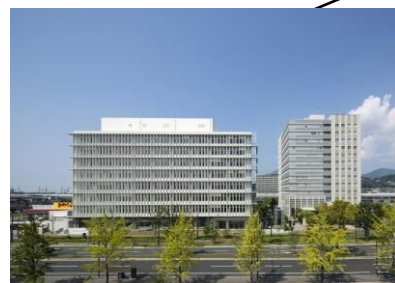
熊本合同庁舎B棟
