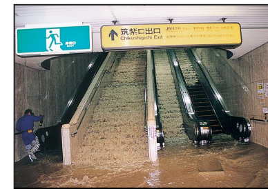
大雨で水浸しになった博多駅周辺
