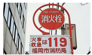
消火栓の標識
