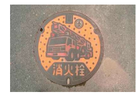
地中にうめられている消火栓
