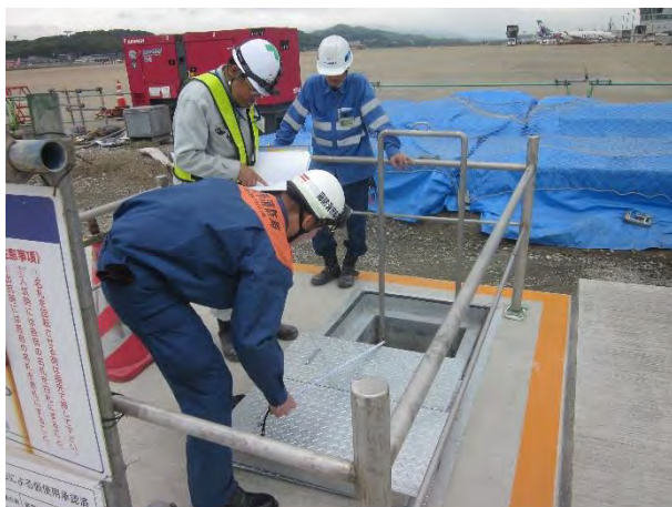
危険物施設の完成検査
