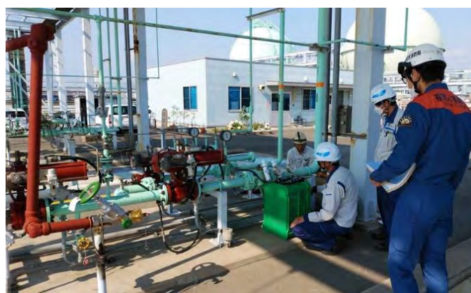
高圧ガス施設の完成検査
