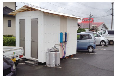
【仮設シャワー】
