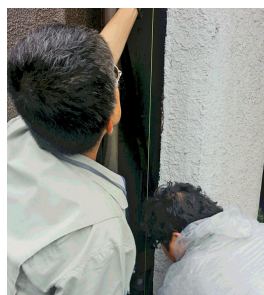
【被災家屋の傾きを計測している様子】
