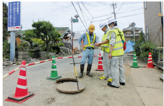
【調査業者との打合せ状況(益城町)】
