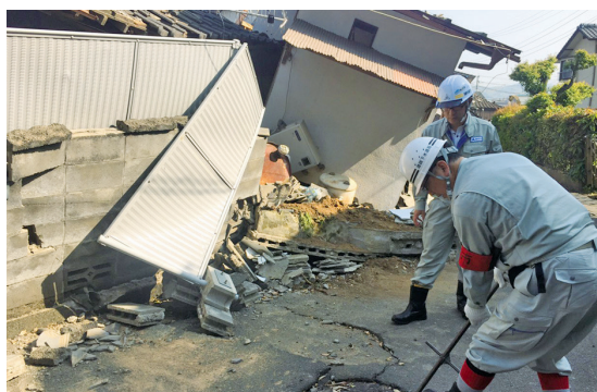
【倒壊家屋付近でのマンホール調査(益城町)】
