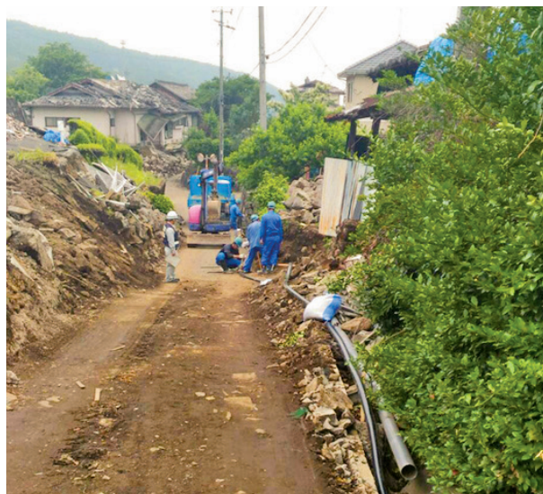
【重機による応急復旧作業】
