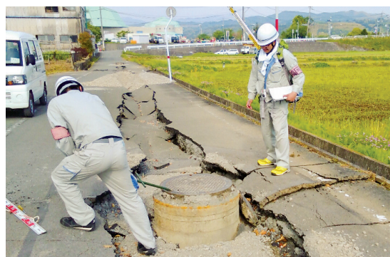
【マンホール調査(益城町)】
