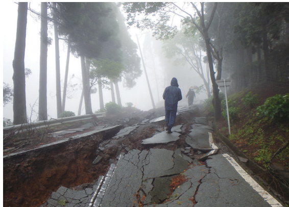
【水道施設の被害状況調査】
