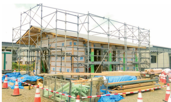
【仮設住宅団地内集会室の中間検査】
