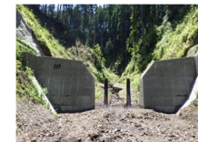
流木捕捉式治山ダム
