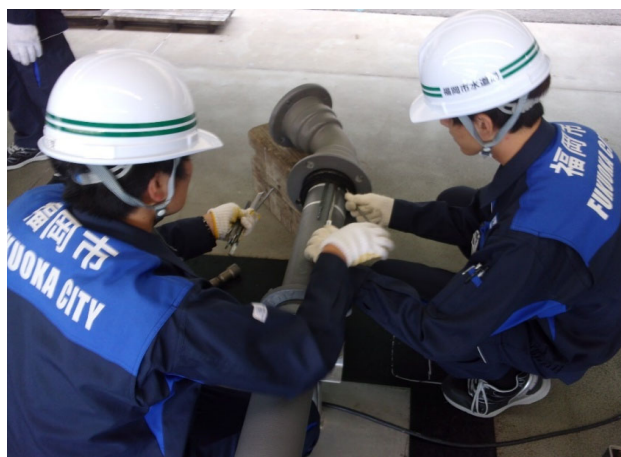
GX形継手(異形管)の解体
