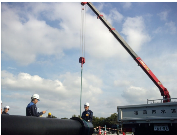
NS形継手(異形管)の接合 (移動送式クレーン使用)
