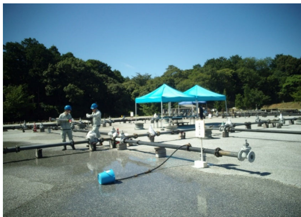
断水～充水～洗管のための 仕切弁及び消火栓等操作
