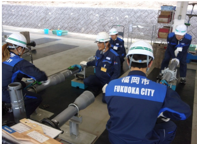
GX形継手(直管、ライナ)の 接合
