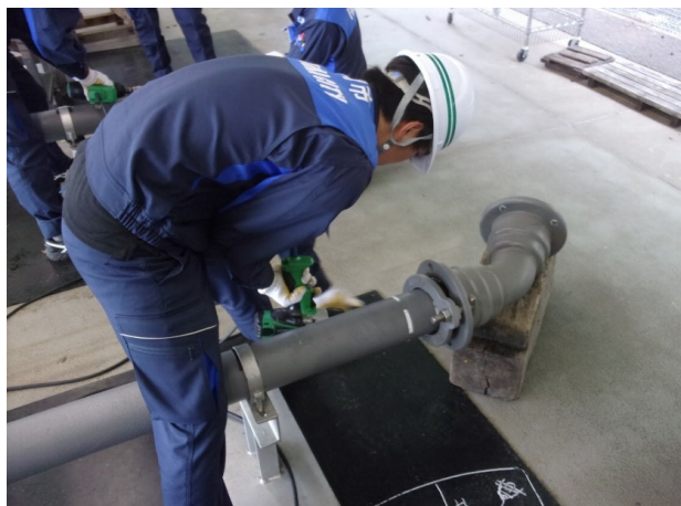
GX形継手(異形管)の接合
