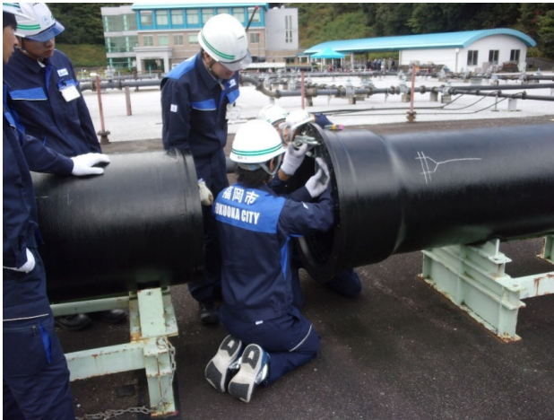
NS形継手(直管)の接合
