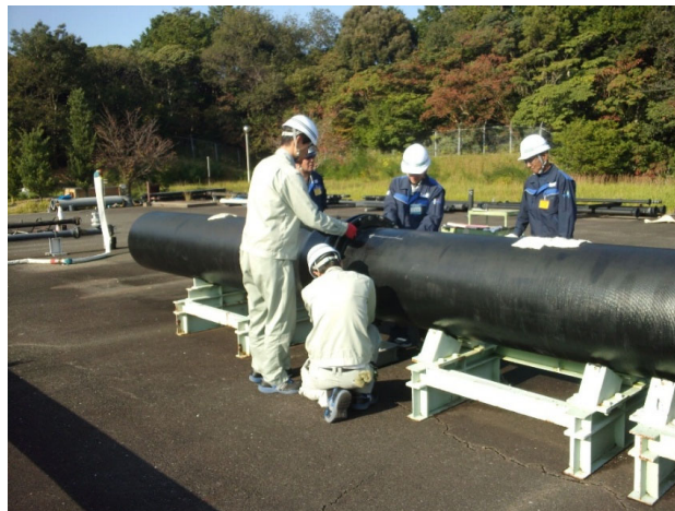
NS形継手(直管)の解体
