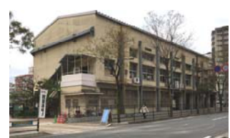
既存体育館(H28.11撮影)
