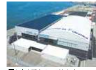
■中央ふ頭クルーズセンター
