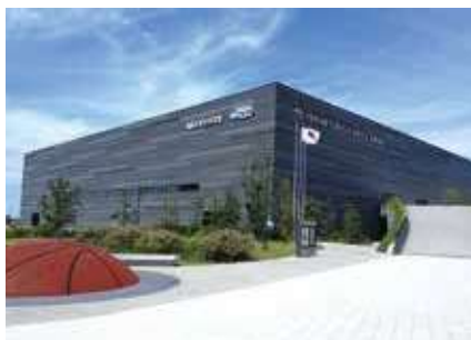
■福岡市総合体育館
