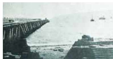
■明治23年に完成した博多港初の木製さん橋
