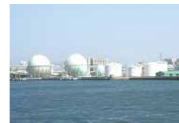
東浜ふ頭 HIGASHIHAMA WHARF
