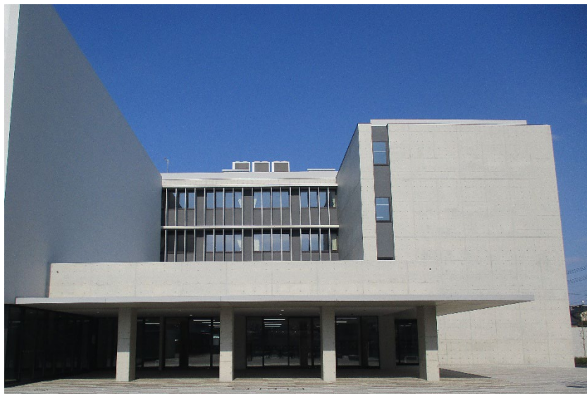
令和8年4月7日に開校した周船寺中学校(ZEB Ready認証取得)
