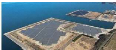
大村メガソーラー発電所（九電みらいエナジー）
