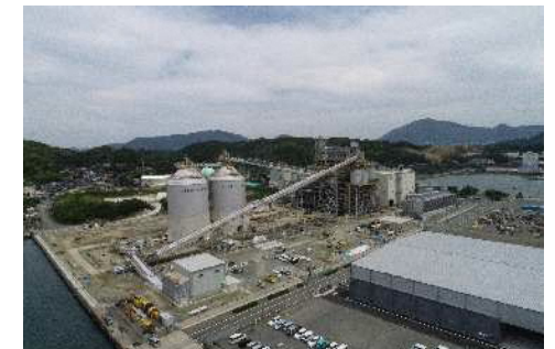
下関バイオマス発電所（山口県下関市）
