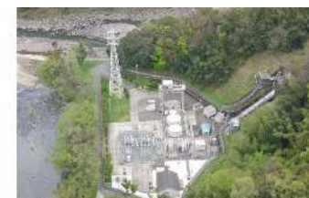
水力発電事業：新竹田発電所
