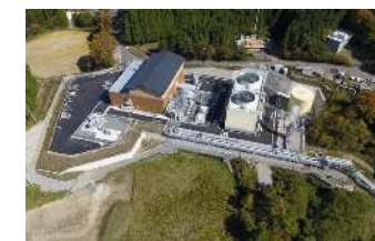
地熱発電事業：大岳発電所
