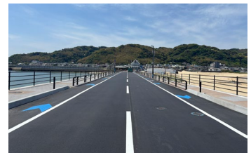
<無電柱化された道路(志賀島)>
