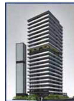
グランドメゾン大濠公園ザ・タワー 積水ハウス株式会社 (ZEH-M Oriented) 2023年7月 竣工
