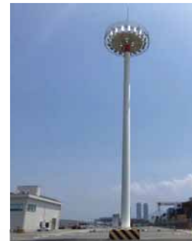
コンテナヤード照明のLED化
