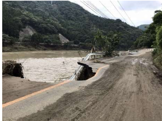
令和2年7月豪雨 出典) 福岡市
