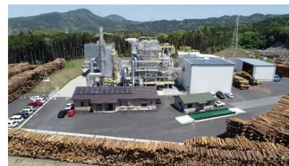
ふくおか木質バイオマス発電所
