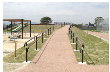
<公園のバリアフリー化> 傾斜部へのスロープや手すりの設置
