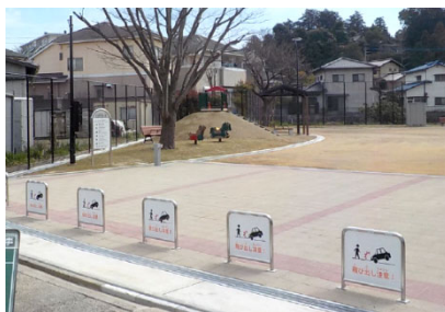
<公園のバリアフリー化> 出入口の幅員の確保・平坦化
