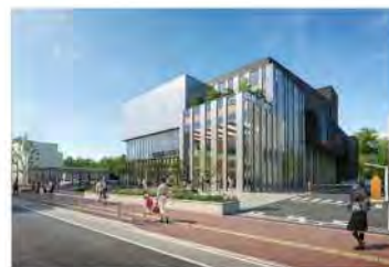
公共施設の大規模改修 (中央市民センター)
