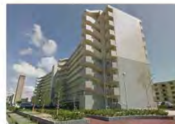
市営住宅の建替え (城浜住宅)
