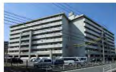
市営住宅の耐震化 (福浜住宅)
