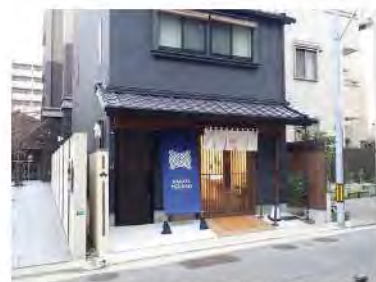
民間建築物の修景助成 （上呉服町）
