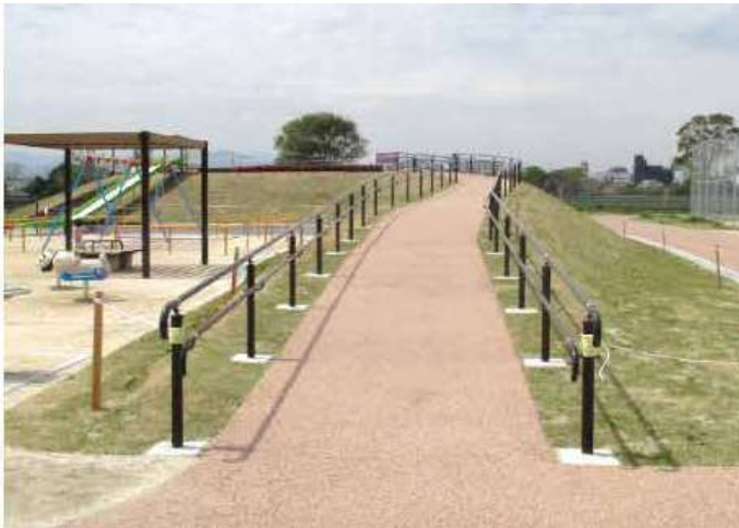
公園のバリアフリー（スロープや手すりの設置）
