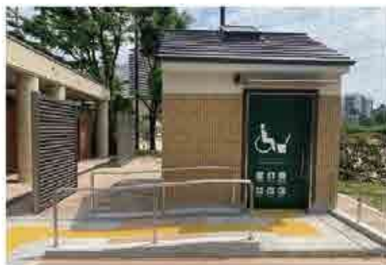
音声案内や介助用の大型ベッド、オストメイト施設などが設置されたバリアフリートイレ
