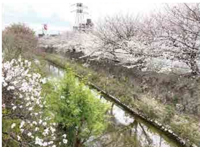
樋井川 (樋井川橋付近)
