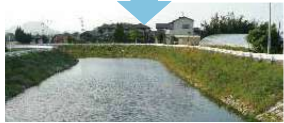
河川の改修（周船寺川の拡幅）
