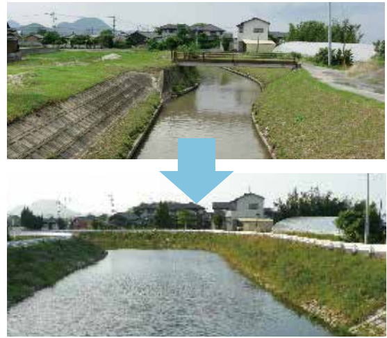
河川の改修（周船寺川の拡幅）
