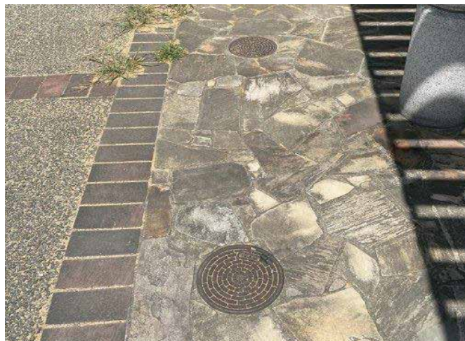
マンホールトイレ（大浜公園）
