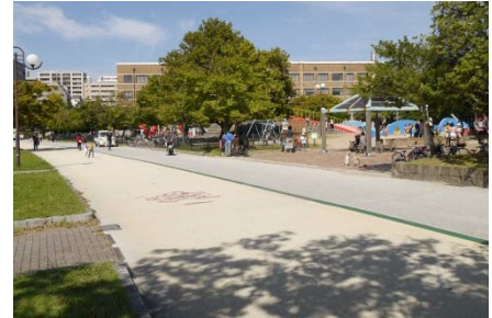
周回園路のゴムチップ舗装
