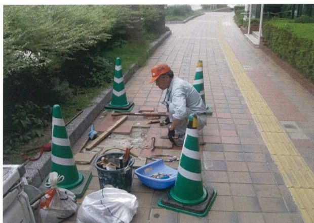
写真：インターロッキングの補修作業
