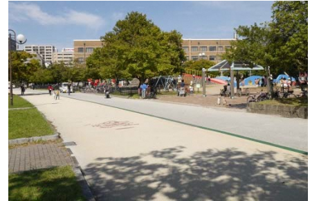
周回園路のゴムチップ舗装
