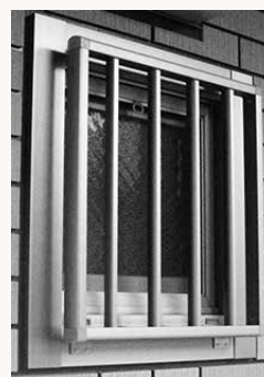
●浴室等の窓への四方枠付面格子の設置
