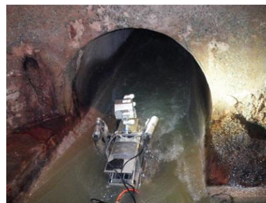
テレビカメラによる 下水道管の劣化状況調査
