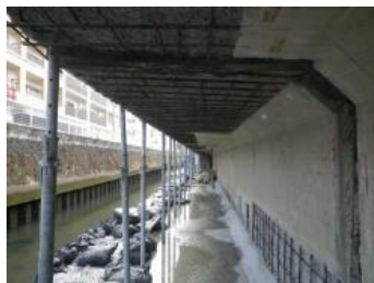
補修中（劣化部のはつり）
