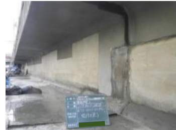
補修完了（断面修復）
