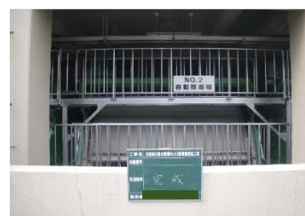
更新完了後（排水機除塵機）
