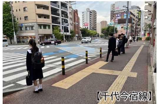
整備事例(防護柵・車止め)
