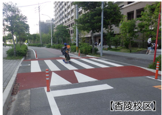
整備事例(スムーズ横断歩道)
