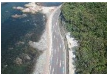
自転車通行空間整備
