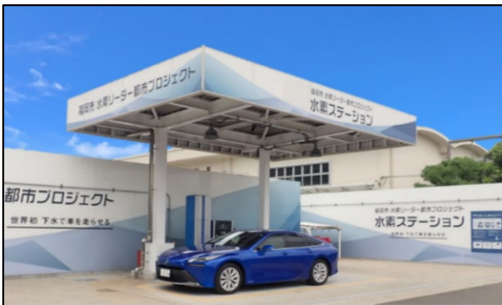
水素ステーション
