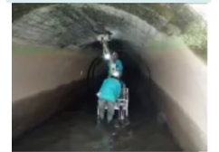
管路内から管路背面の地盤の空洞を調査
