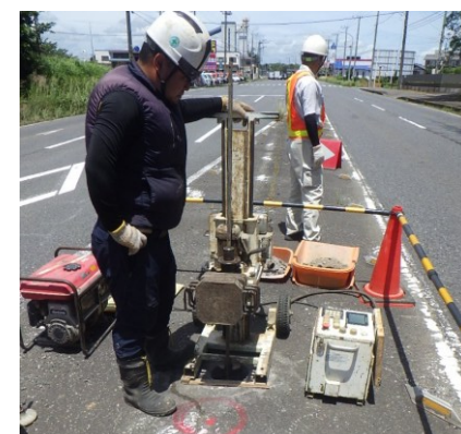
貫入試験による空洞調査
