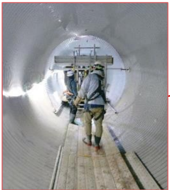
破損した下水道管の復旧が完了
