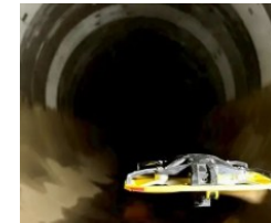
ドローンによる目視調査
