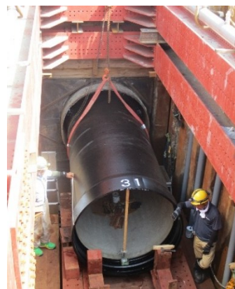
水道管路の更新イメージ
