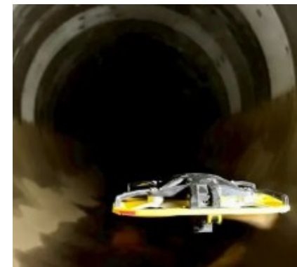
ドローンによる目視調査
