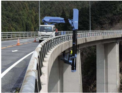
(橋梁点検車を使用)
