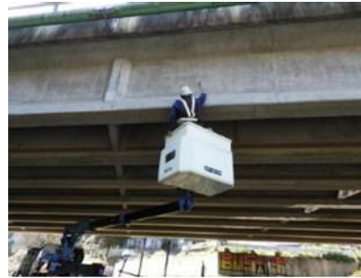
(高所作業車を使用)
