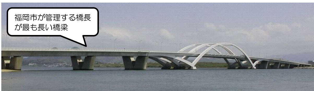
写真 3-1 海の中道大橋（橋長 750m）
