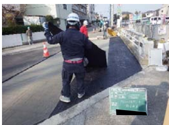
④【防水シート 設置】
